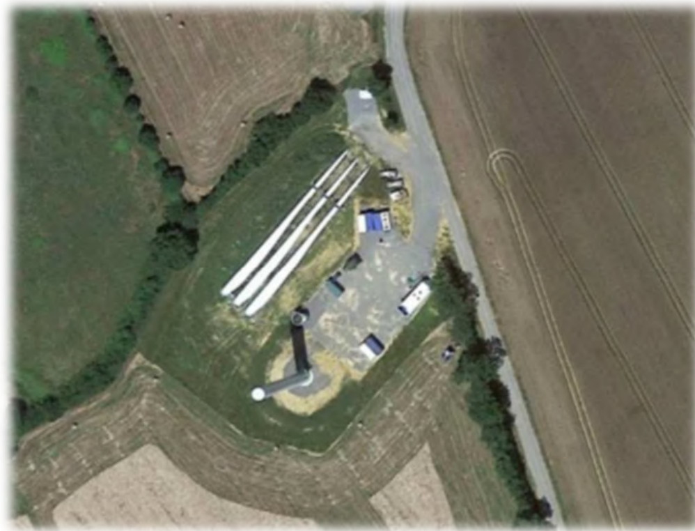
Illustration 4 : vue aérienne d'une plateforme et de ses abords en phase chantier
